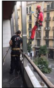
Trabajos en altura realizados en el edificio Torre Banc Sabadell en Barcelona.
